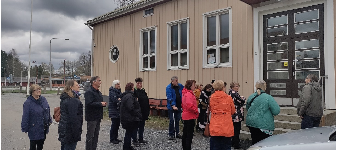
Ulkoverhoilun kunnostus Keikyän vanhalla puukoululla herätti ihastusta – myös uudet älylukot herättivät keskustelua retkeläisten keskuudessa.
